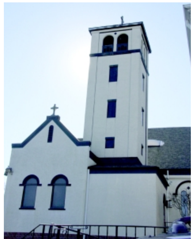
A torre da igreja de São Francisco Xavier
